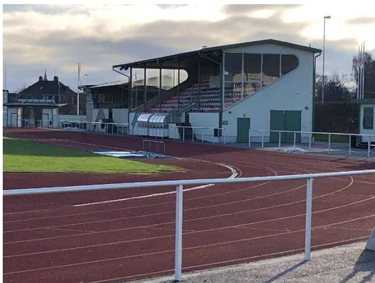
Idrottsplatsen med läktarbyggnader.
