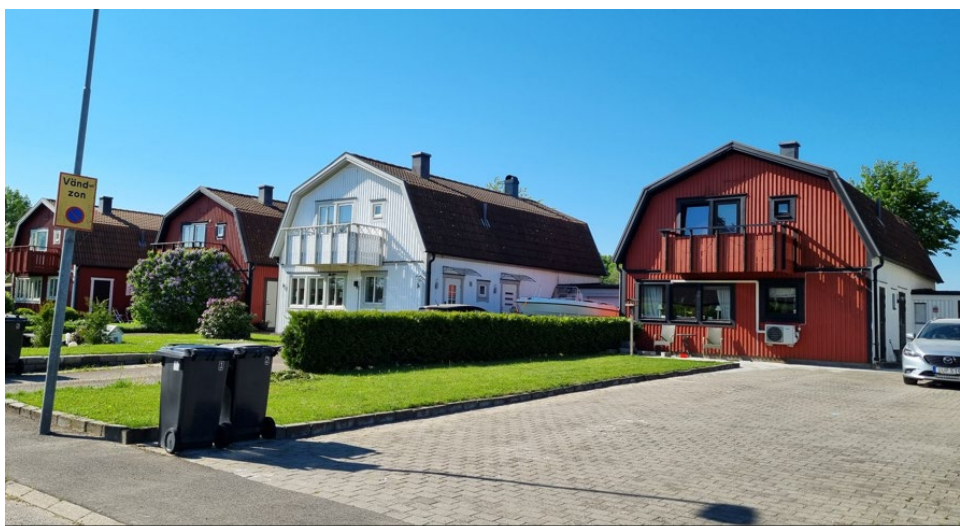
Figur 12- Gatuvy - De kedjehusen vid Kattfotsvägen
